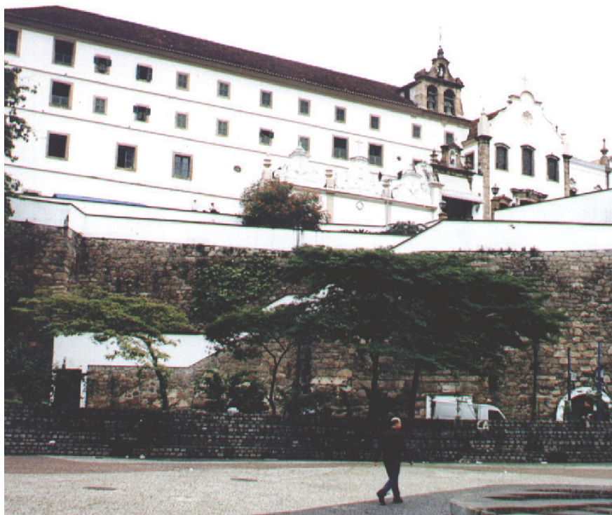
Vista lateral do Convento Santo Antônio, construído no século XVIII
