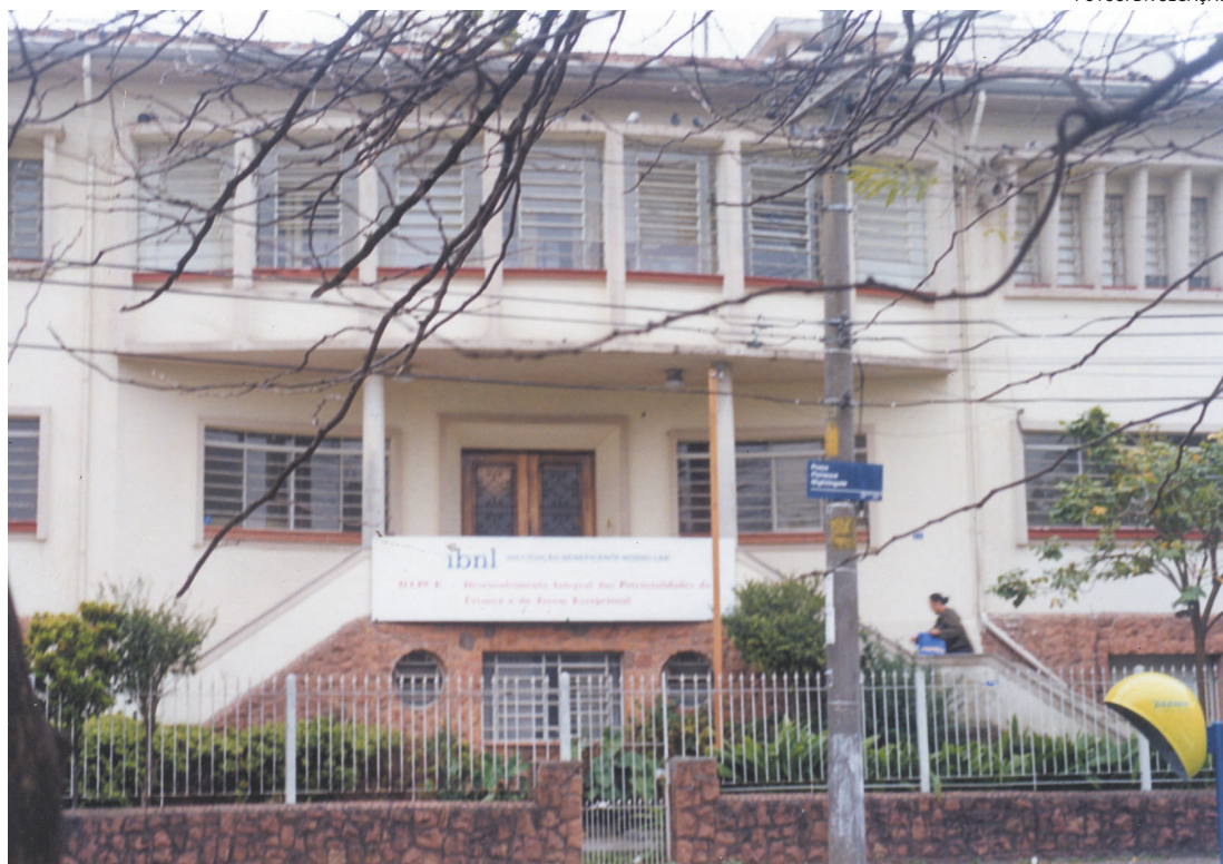
Prédio onde funcionam as terapias individuais, em grupos e o externato
